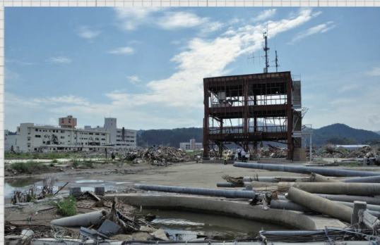
地震による直接的な被害の他、津波による被害で多くの路線が運転を停止した
